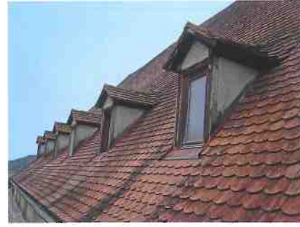
Abb. 22: Bestand der Dachgauben
