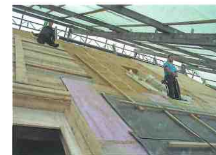
Abb. 19: Notdächer schützten einzelne Abschnitte beim Sanieren und Dämmen mit Holzfaserplatten.
