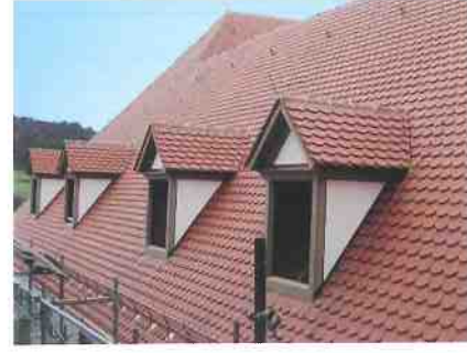
Abb. 23: Die neuen, mit VIP gedämmten Dachgauben
