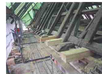
Abb. 20: Im Bereich der Aufschieblinge gab es viel auszubessern.
