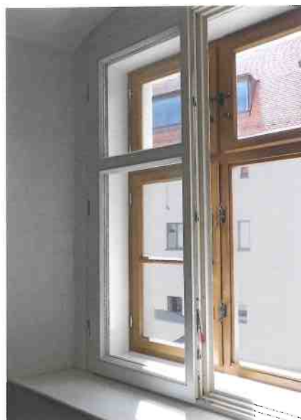
Abb. 15: Die historischen Fenster wurden erhalten und durch innen liegende Flügel ergänzt.
