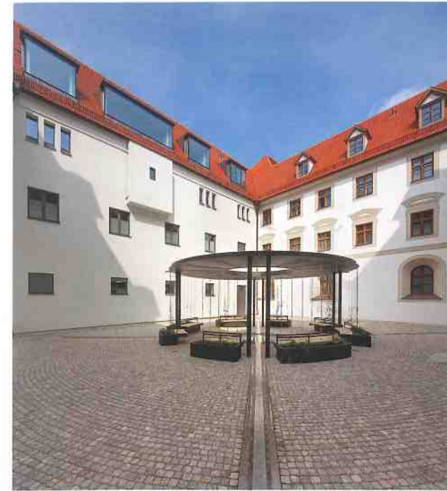
Abb. 24: Deutlich abgesetzt ist die Fassade des neuen Mitteltrakts mit der Kapelle unter dem Dach.
