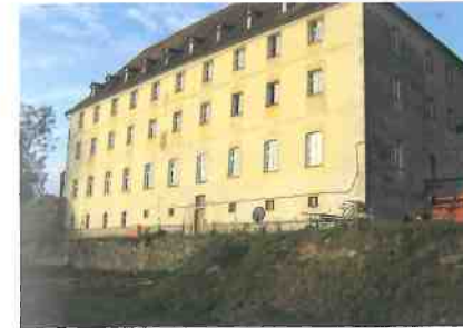
Abb. 2: Ostseite vor der Sanierung
