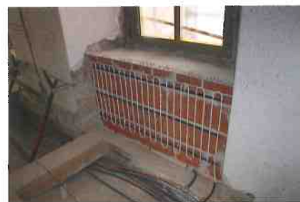
Abb. 17: Die Heizkörpernischen wurden mineralisch gedämmt und temperiert.
