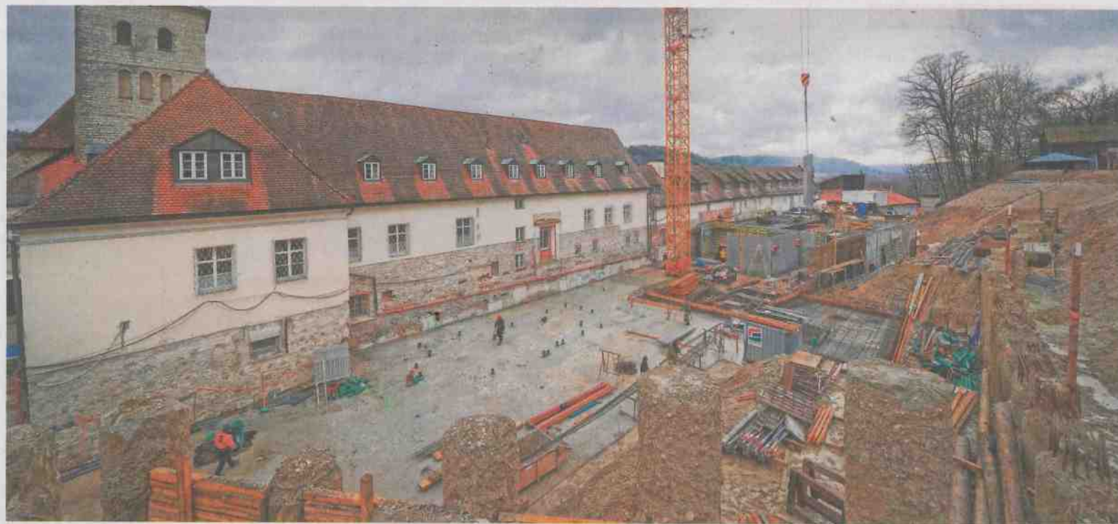
Erst nach umfangreichen Hangsicherungsmaßnahmen konnte am Kloster Plankstetten mit dem dritten Bau- und Sanierungsabschnitt begonnen werden. Einweihung soll im kommenden Jahr sein.
