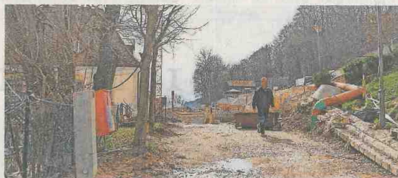
Auf der Baustelle geht der Betrieb weiter.
