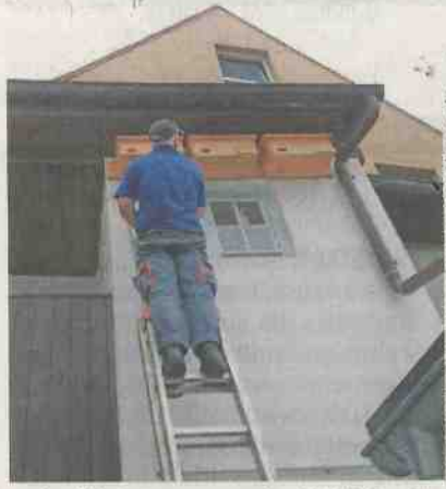
In der Klostersgasse wurden Nisthilfen für Mauersegler und Schwalben montiert.
