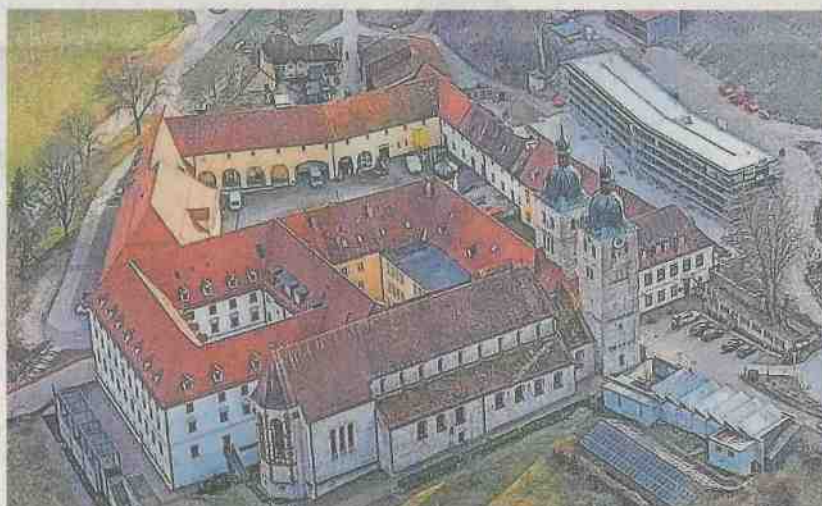
Das Kloster Plankstetten aus der Vogelperspektive: Rechts oben im Bild ist die Baustelle „Strohballenhaus“ zu sehen.
