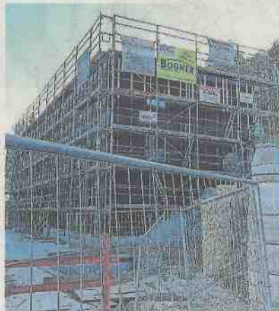
So sieht die Baustelle des Hauses St. Wunibald aktuell aus. FOTO: NEUMAYER
