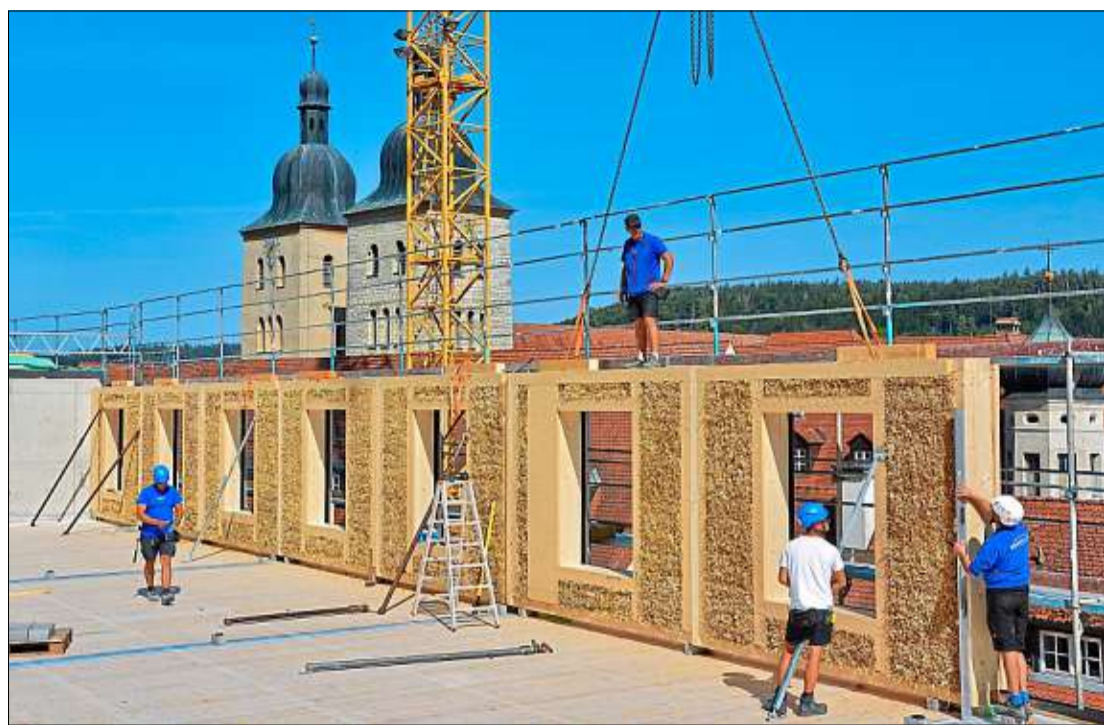
Einen ebenso ökologischen wie aufsehenerregenden Weg hat die Klostersgemeinschaft Plankstetten für den Bau des Hauses St. Wunibald gewählt. Es entsteht das größte strohgedämmte Haus in Süddeutschland. Bei einem Pressetermin wurde das Großprojekt nun noch einmal im Detail vorgestellt – und über den erfreulichen Baufortschritt informiert. Fotos: Adam (3)/Märtl
